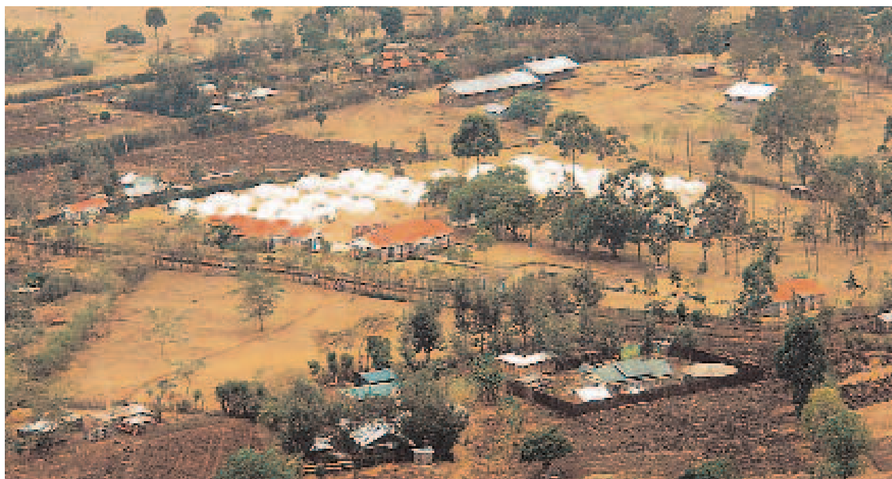
Auf dem Areal des Rhein-Valley-Hospitals sind durch das SRK 50 Zelte bereitgestellt worden.
